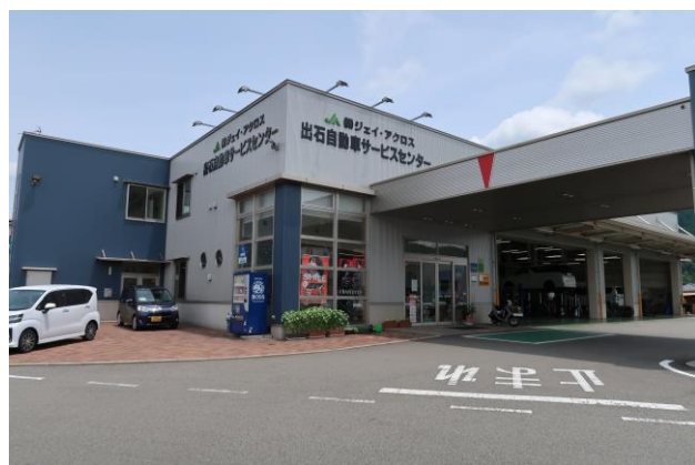
出石自動車サービスセンター
